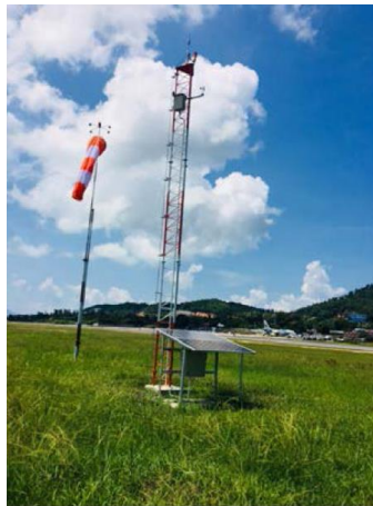
รูปที่ 2.1-28 การทดลองโครงการติดตั้งระบบโซลาร์เซลล์พลังงานแสงอาทิตย์
