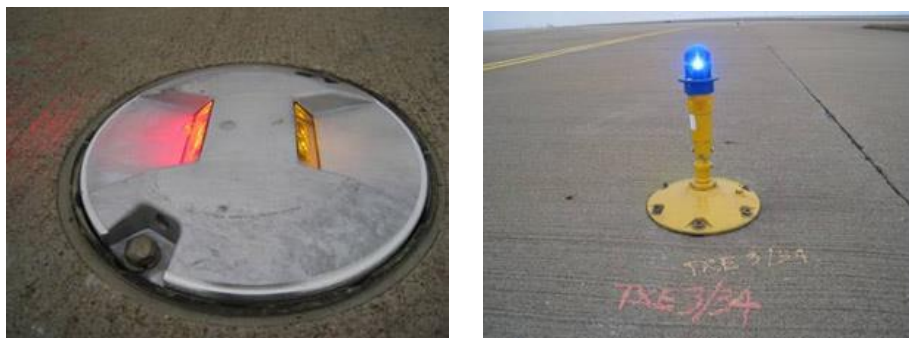
รูปที่ 2.7.1-5 การเปลี่ยนหลอดไฟ LED ของอุปกรณ์ที่ทางขับ Airfield Ground Lighting (AGL) of Taxiway
