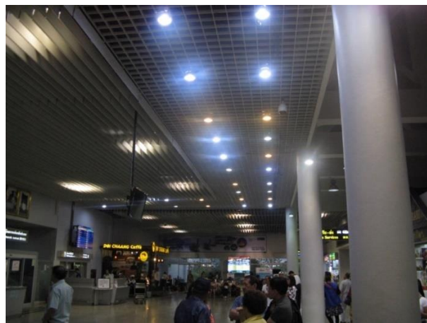
รูปที่ 2.4.1-9 การเปลี่ยนหลอดไฟแบบ LED ที่อาคารผู้โดยสาร
