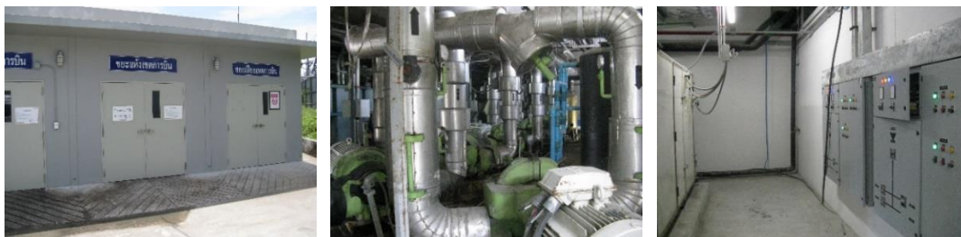
รูปที่ 2.4.3-5 การใช้ไฟฟ้าของท่าอากาศยานภูเก็ต
